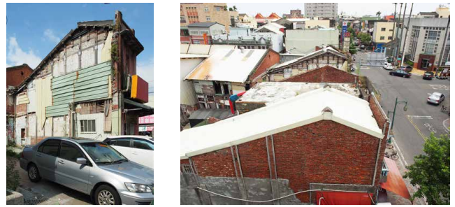
図 6 延平路 246 号 延平路の拡幅で削られた街屋
