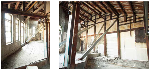
図 5 延平路 246 号 丸太の桁がレンガのファサードに支えられる
