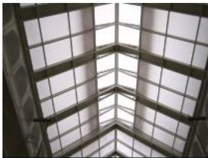
図5 改修後屋根に取り付けられた換気窓
